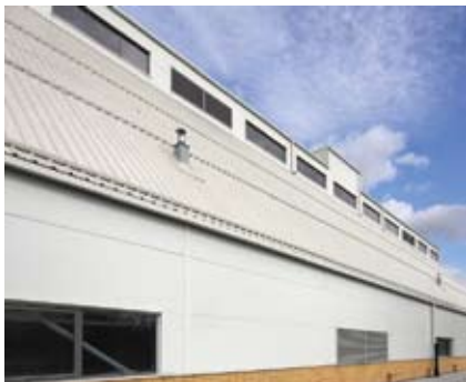
ELEKTROCIĘPŁOWNIA w Rybniku
